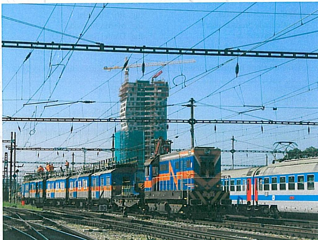
**Výměna nosných lan trakčního vedení v žst. Brno hl.n. 2.část**
